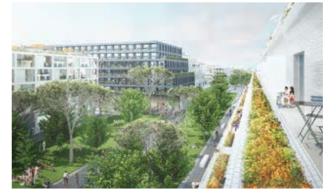
Vue depuis les gradins de l'axe central (source MDP, XDGA FAA, 2017)
